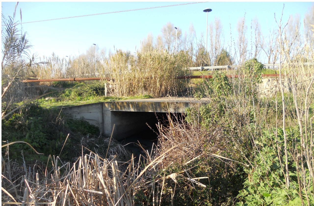
Figura 20 Vista sbocco canale tombato
