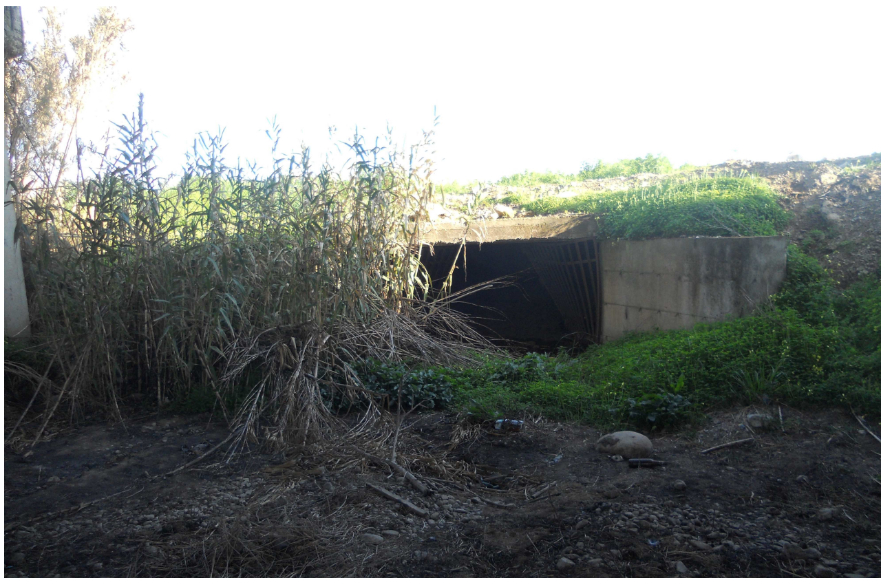
Figura 20 Vista sbocco canale tombato
