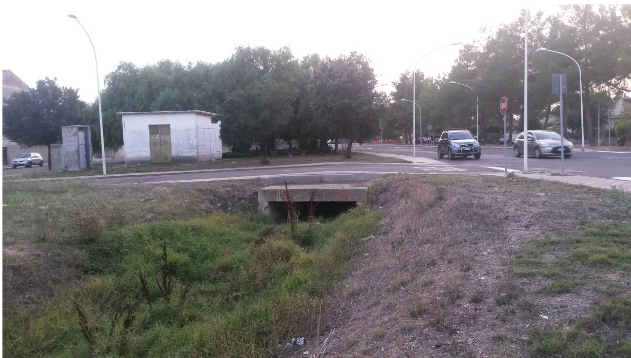
Figura 22 Vista sbocco canale tombato
