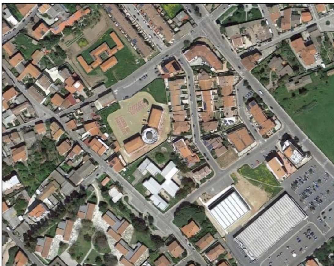
Figura 10 Vista zona di emergenza Poliambulatorio, Via Giardini.
