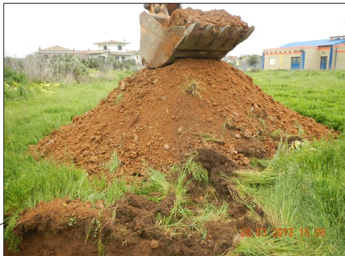
**FOTO 4/5** – Esecuzione di pozzetto geognostico.
