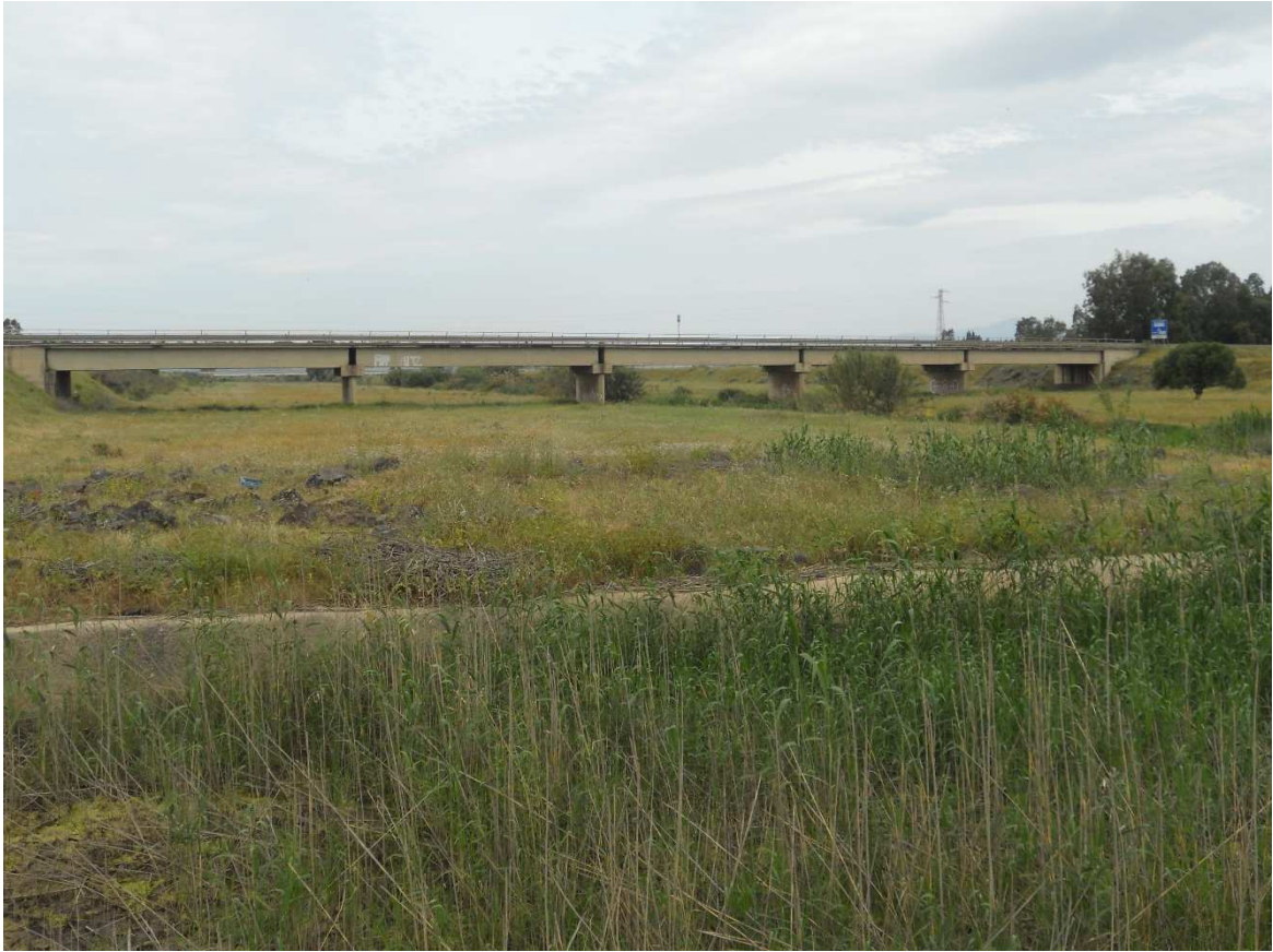
Figura 7 Rio Mannu di San Sperate ponte su SS 196
