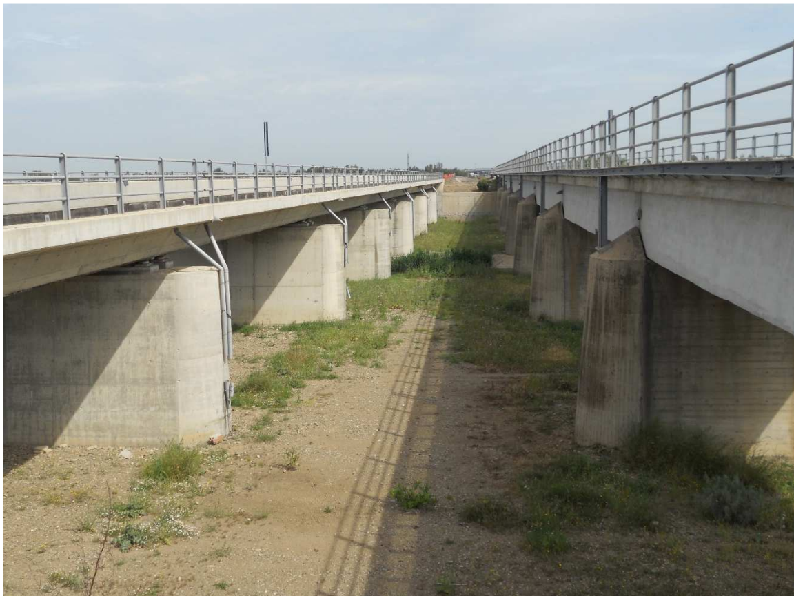
Figura 8 Rio Mannu di San Sperate – Doppio Ponte Ferroviario Linea Cagliari - Sassari
