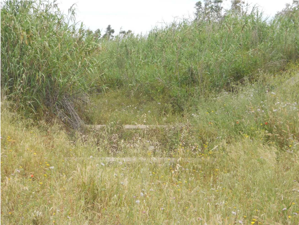
Figura 12 rio Concias sezione trapezia con forte presenza di vegetazione
