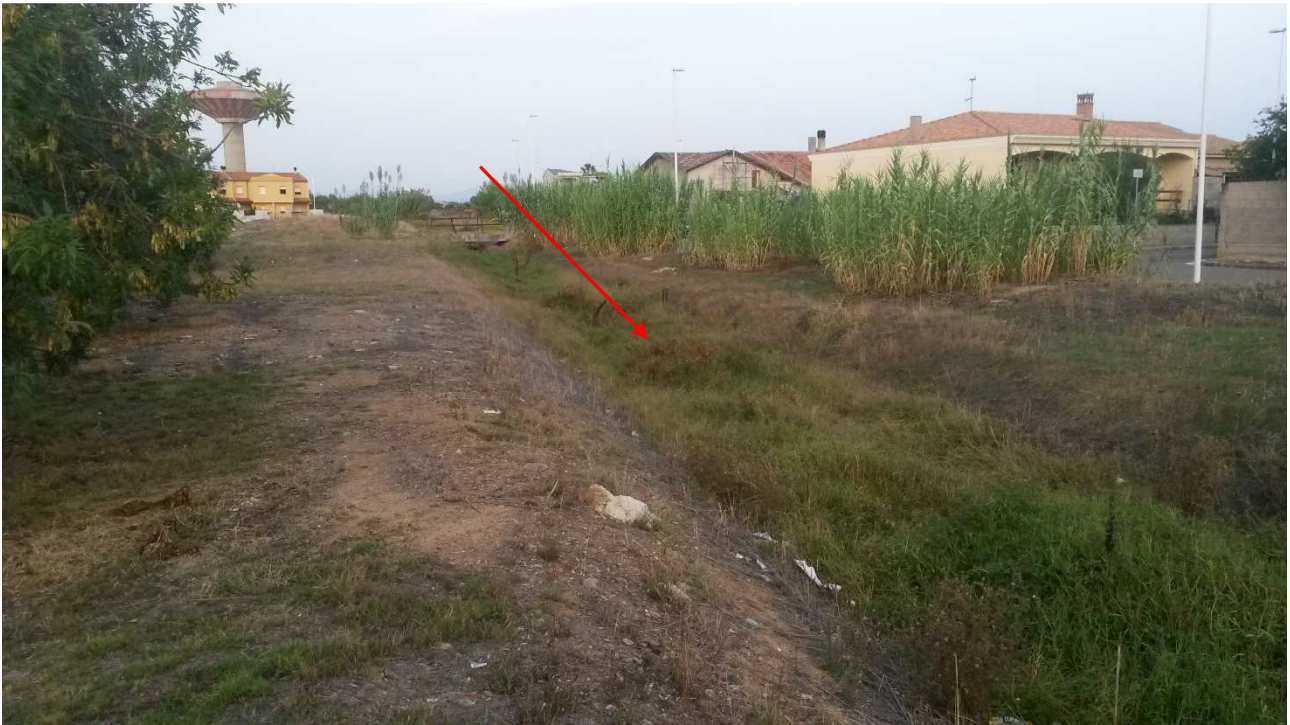
Figura 16 Tratto montano sezione trapezia in terra
