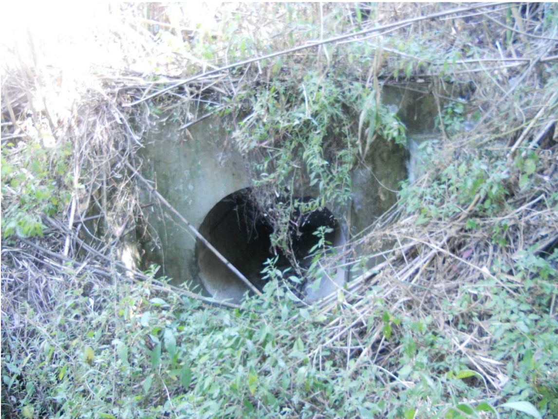
Figura 21 Attraversamento SS 130 Tubolare 1 m
