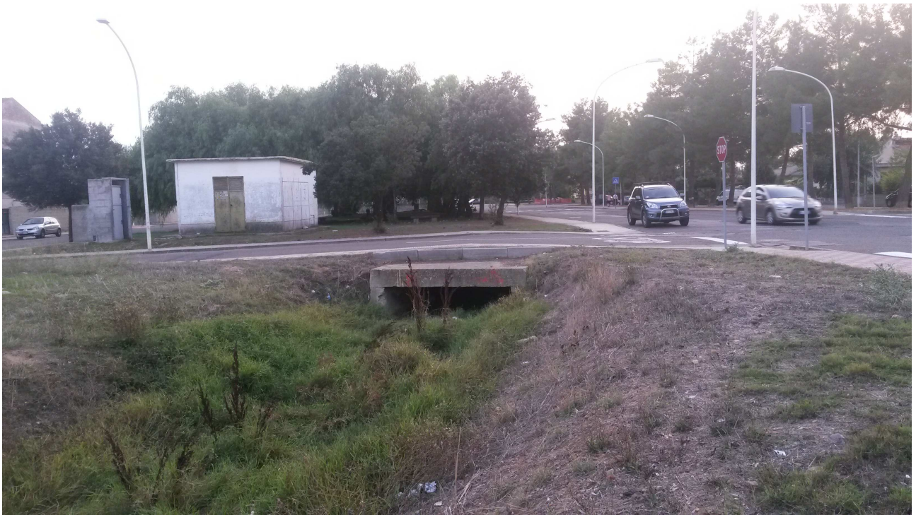
Figura 7 Vista sbocco canale tombato
