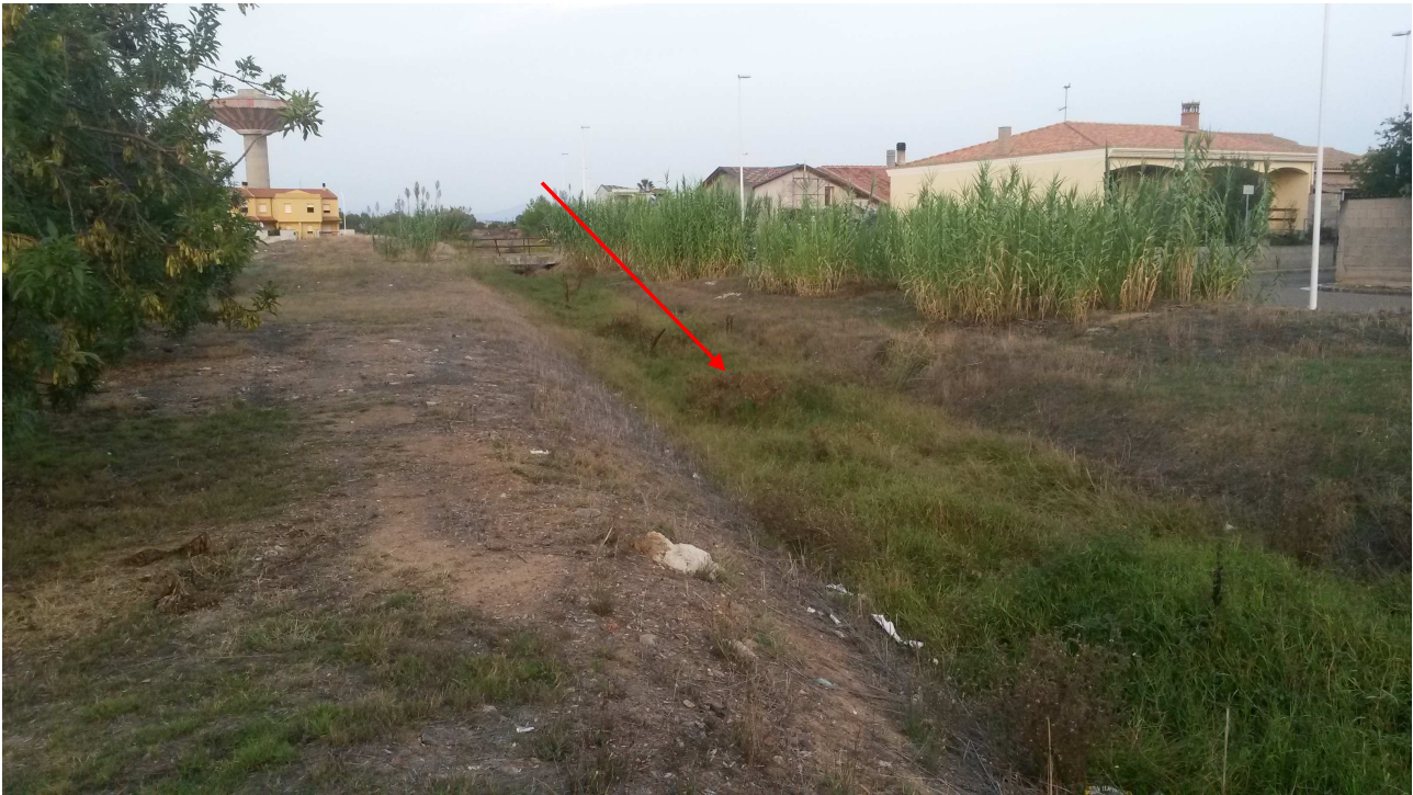
Figura 3 Tratto montano sezione trapezia in terra
