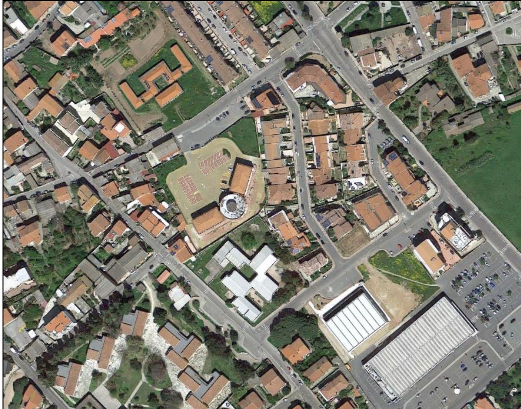
Figura 10 Vista zona di emergenza Poliambulatorio, Via Giardini.
